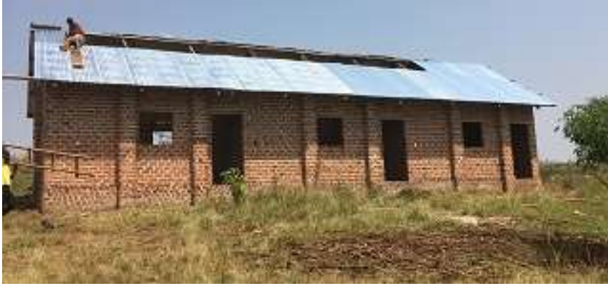
写真④ トタン屋根も付けてもうすぐ完成！
