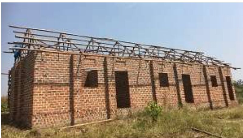
写真③ 屋根の枠組みできました！
