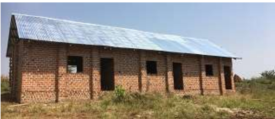
写真⑤ 無事に屋根完成しました！
