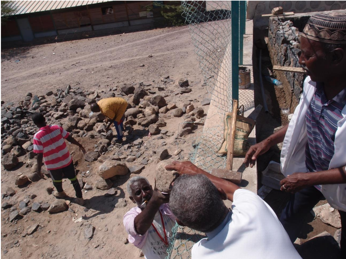
No3 医療職者、州庁技術者が力を合わせて貯水槽の外壁の石を運ぶ様子
