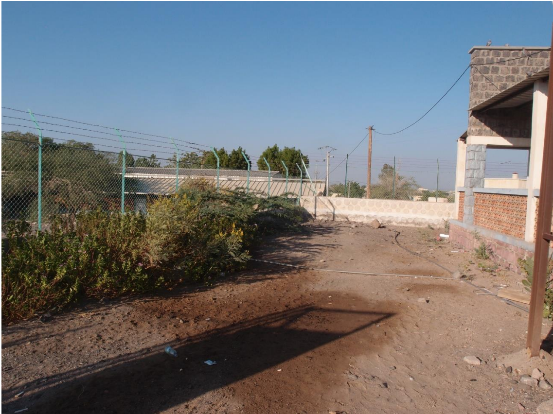
No1 2016年11月5日 貯水槽着工前の様子
