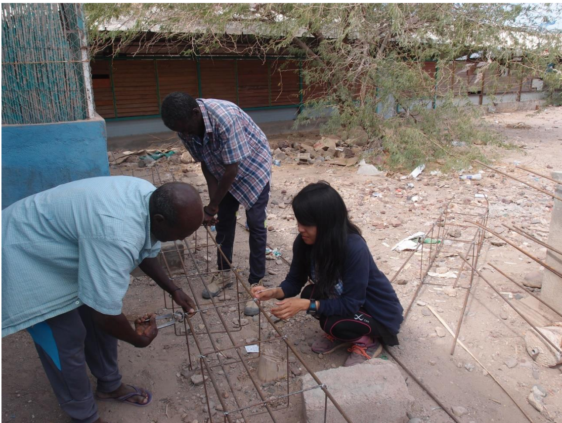
No2 州庁技術者に柱の骨組みの作り方を聞いている様子
