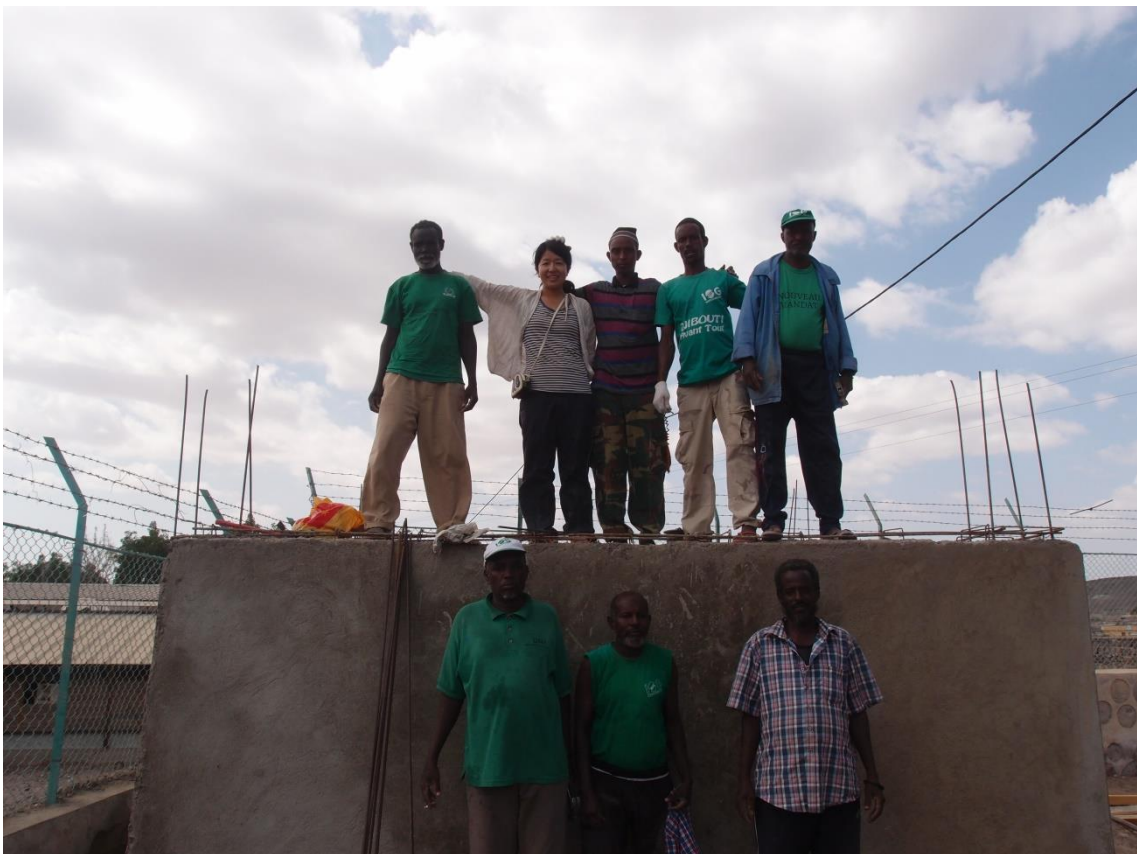
No4 貯水槽建設に取り組む州庁技術者とボランティア
