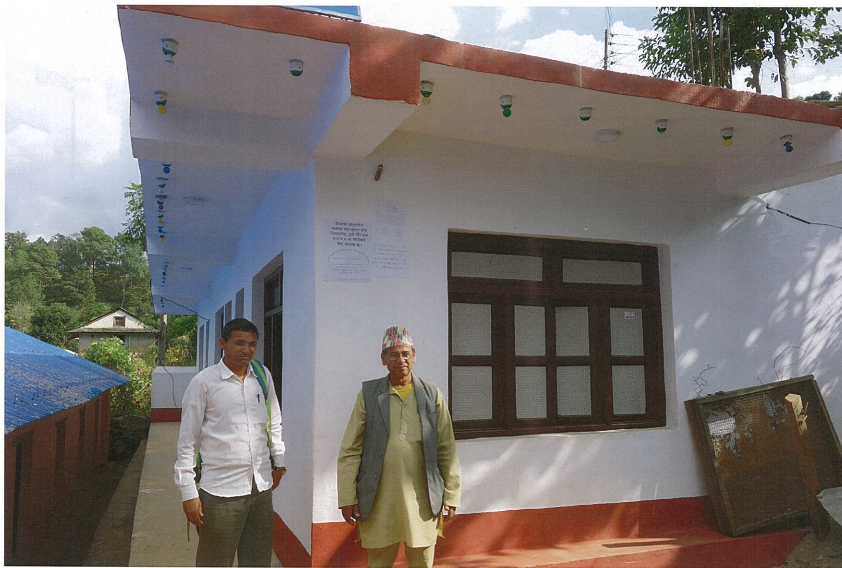
完成したビムシュワール寺子屋
