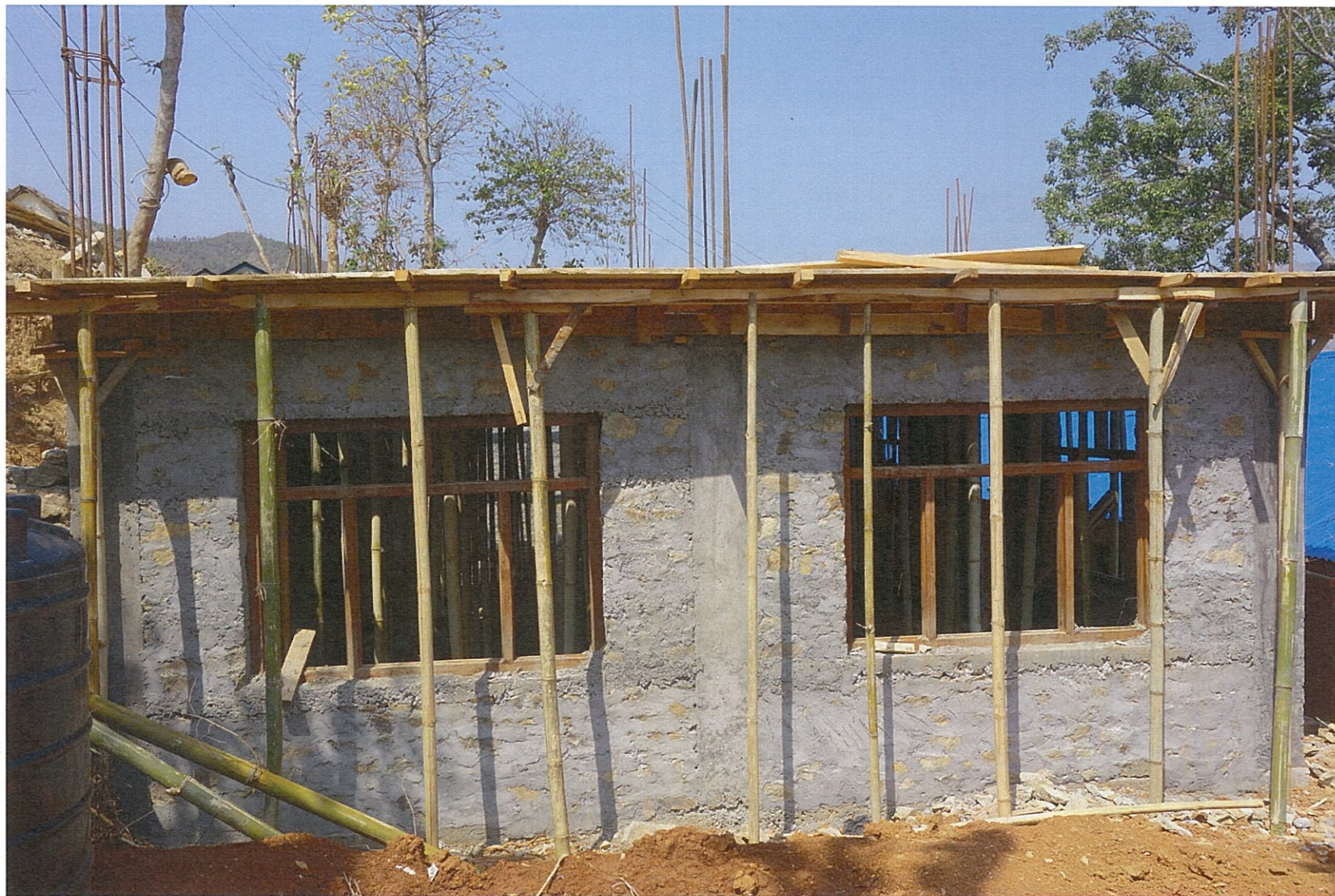
建設中の寺子屋
