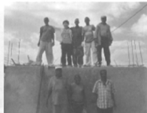
技術者とボランティアで貯水槽建設に取り組みました。
